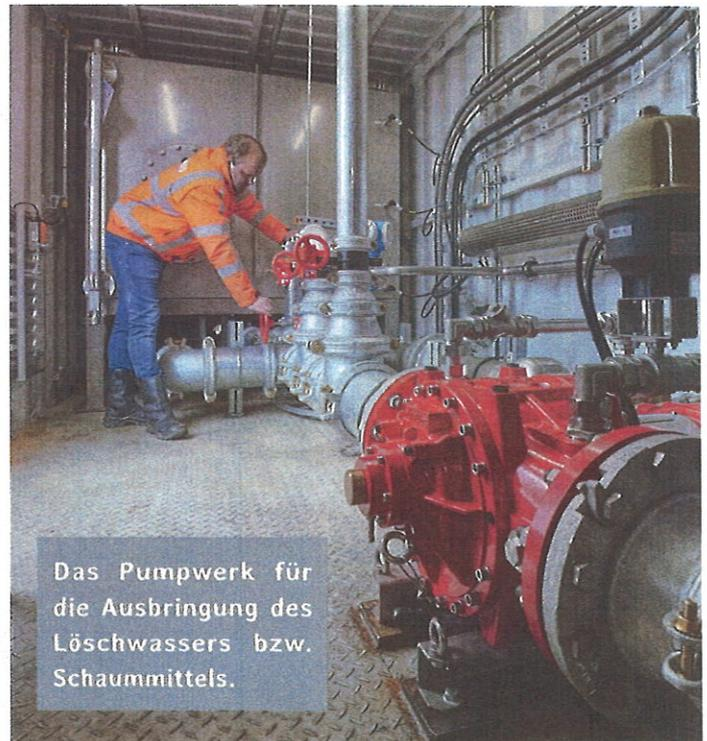
Das Pumpwerk für die Ausbringung des Löschwassers bzw. Schaummittels.
