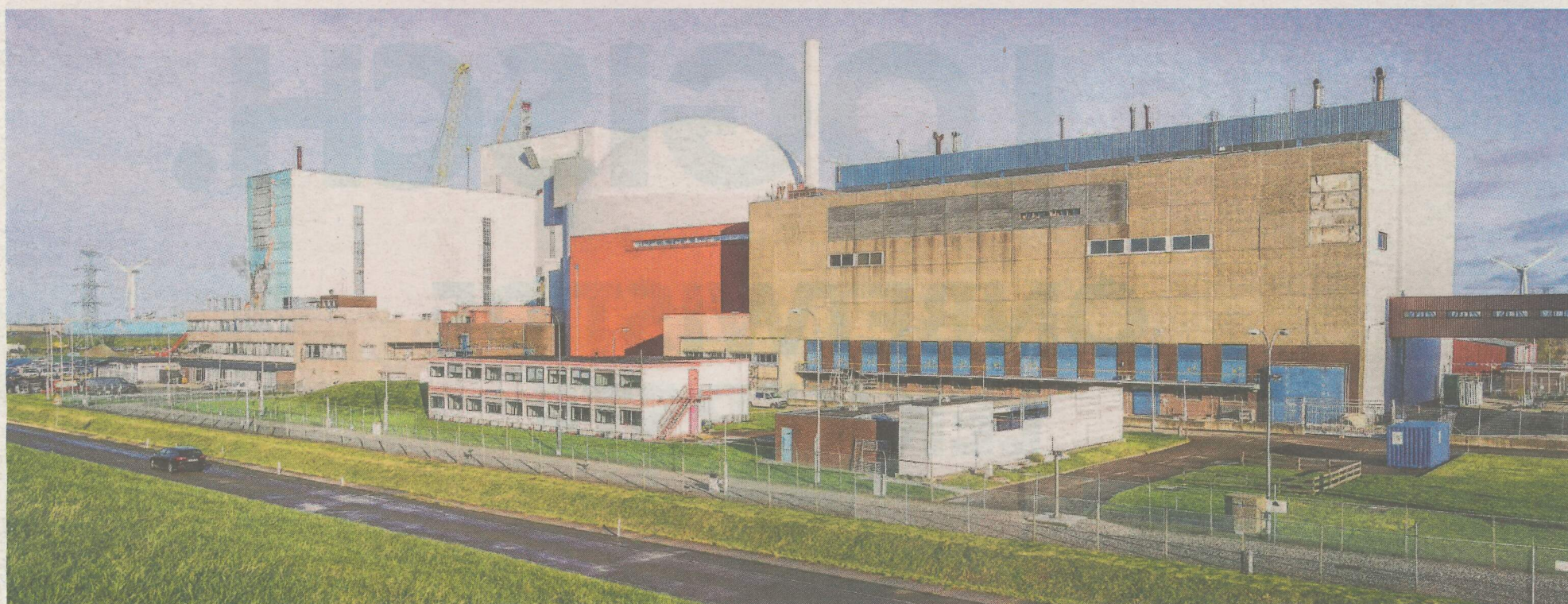
De huidige kerncentrale in Borssele. Het kabinet is van plan om twee nieuwe kerncentrales te bouwen. FOTO LEX VAN LIESHOUT/ANP
