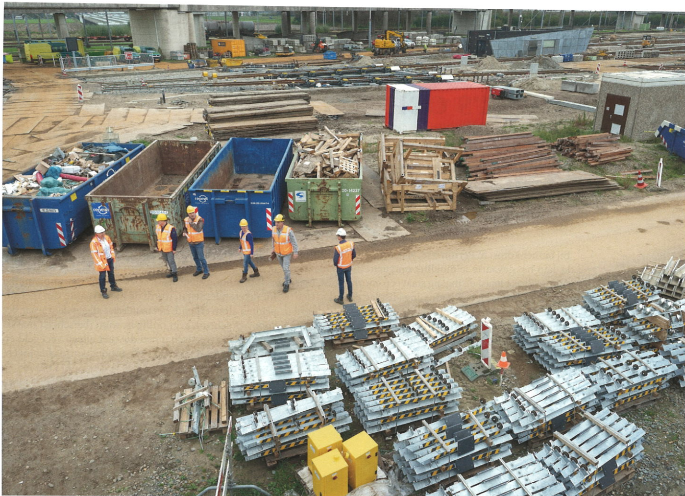
Op het werkeiland liggen onderdelen te wachten op installatie.
