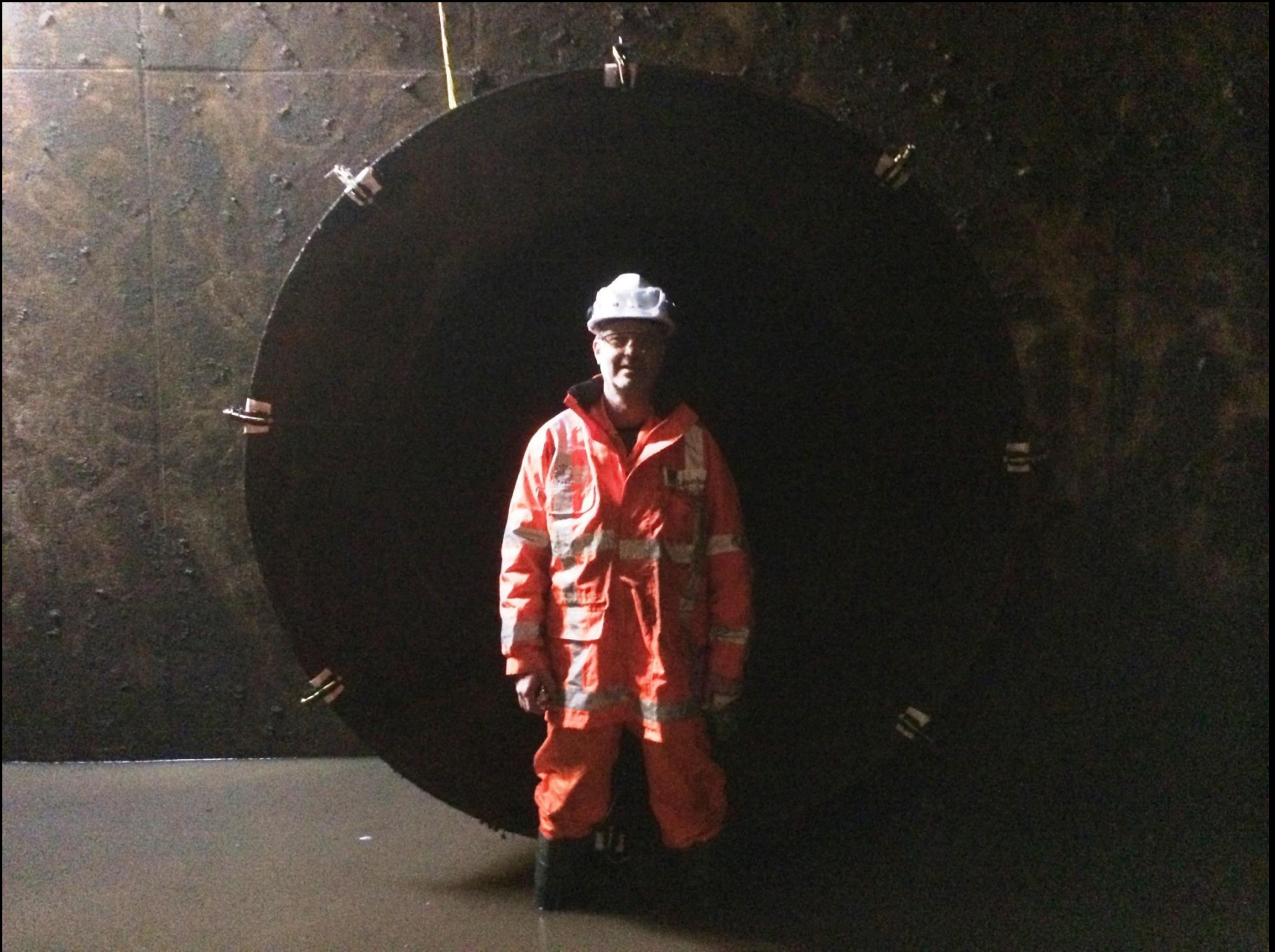
Industriewaterleiding Evides diameter 1,80m lengte 1 km
