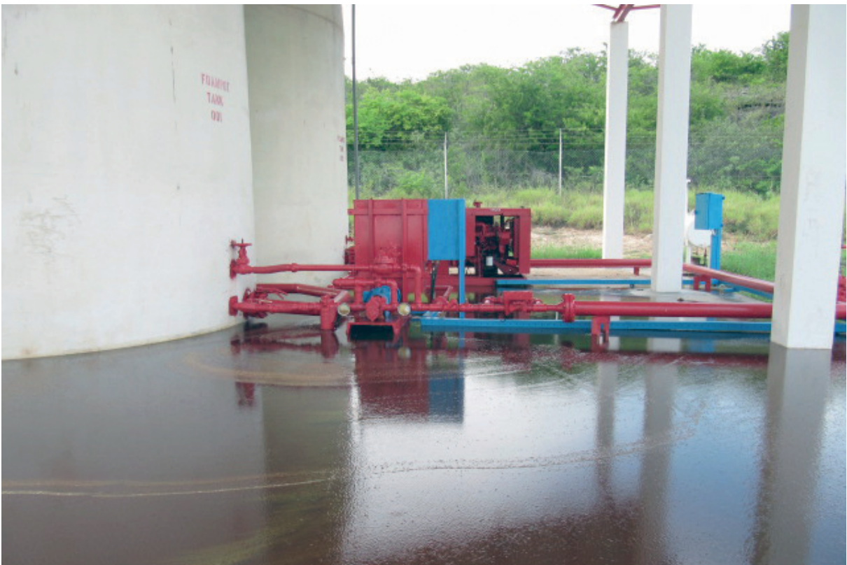
Foto 10: Voorraadtank met schuimvormend middel in voetbad. Bron: VROM
