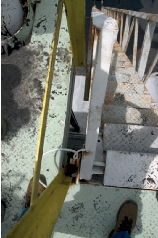
Foto 3: Tank 1901, lus in verbindingkabel, trap/wand
