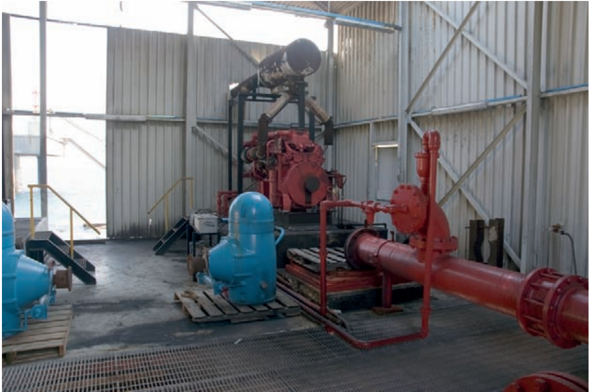
Foto 5 en 6: Beide bluswaterpompen (blauw) op een pallet
