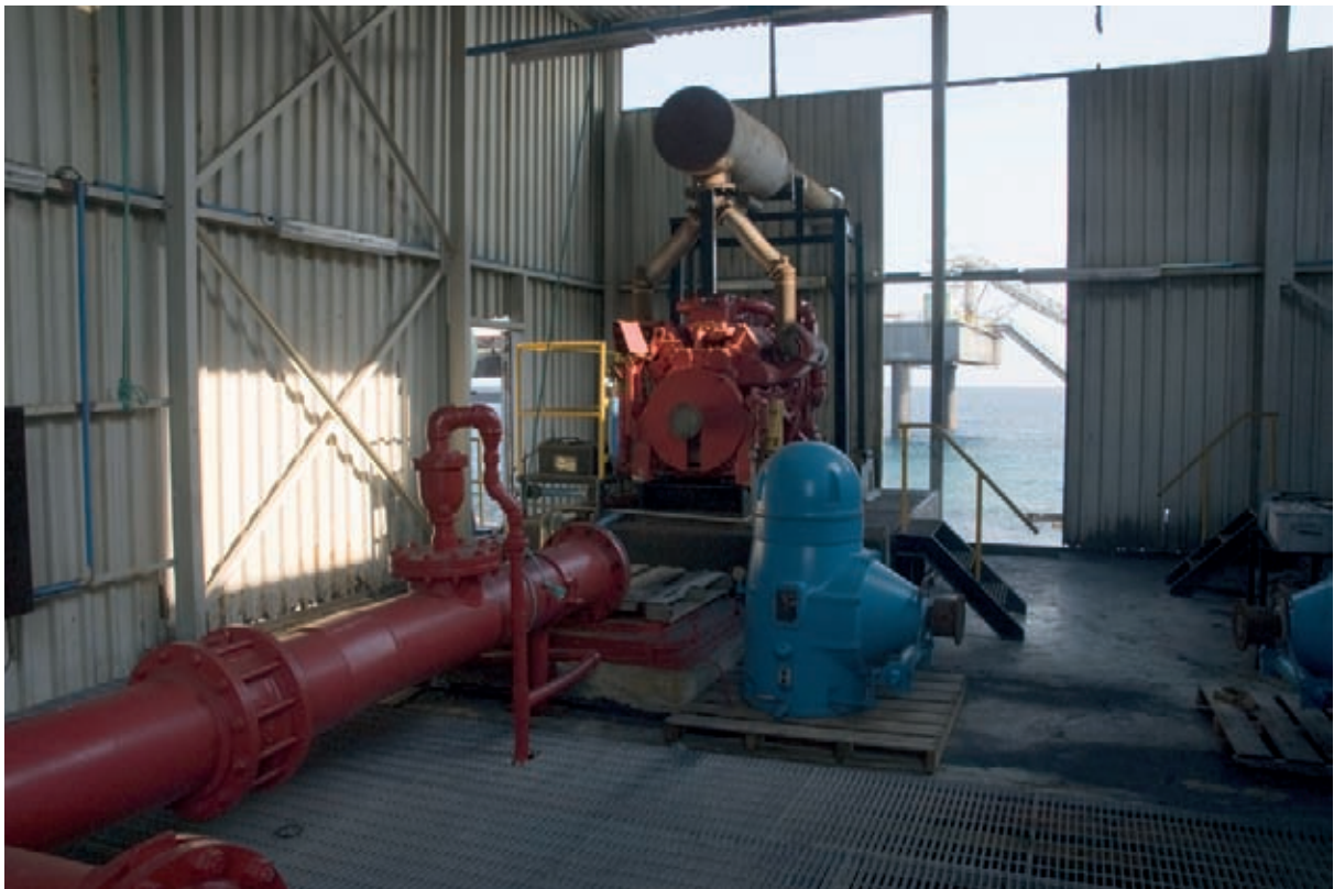
Foto 5 en 6: Beide bluswaterpompen (blauw) op een pallet
