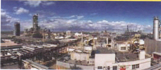
De luchtfoto van chemiepark Chemelot laat zien hoe dicht alles op elkaar zit, fabrieken en snelwegen.
