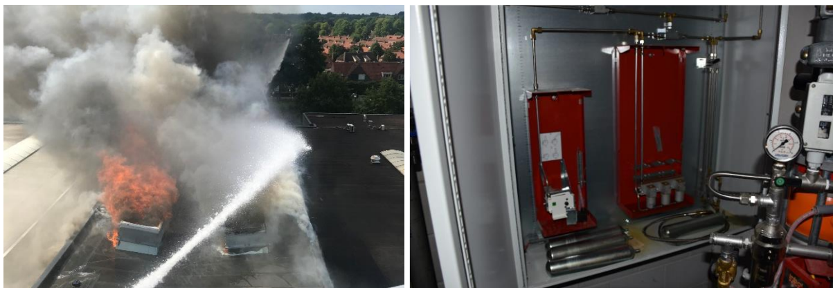
Figuur 2A en 2B: Op de foto links zijn de gesloten dakluiken te zien tijdens de initiële fase van de incidentbestrijding. Op de foto rechts is de inhoud van de cilinderkasten te zien: de rode cilinderkasten zijn leeg, er liggen vier zilvergrijze cilinders los onderin de beige alarmkast.
